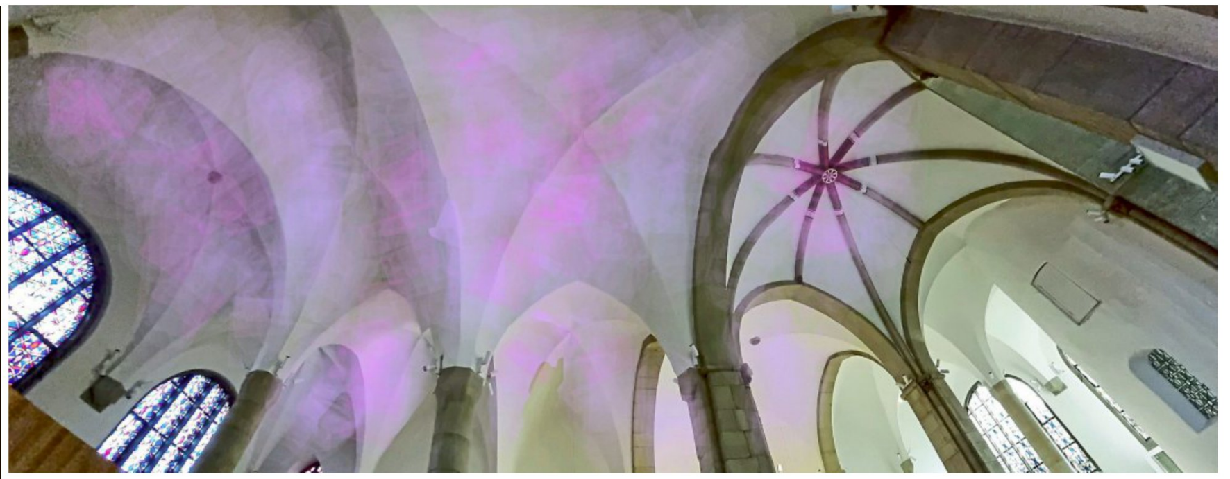
Das Kirchengewölbe wird während der Ausstellung illuminiert.
